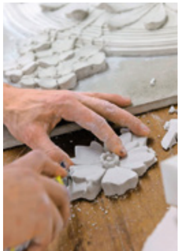
Formen aus Silikonkautschuk zum Guss von Ornamenten (o.). Eine Deckenrosette wird repariert (u.).
